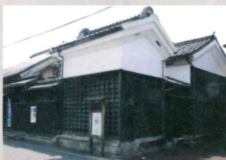
湯の山街道の「舟板壁」
