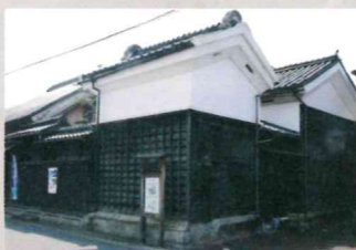
湯の山街道の「舟板壁」
