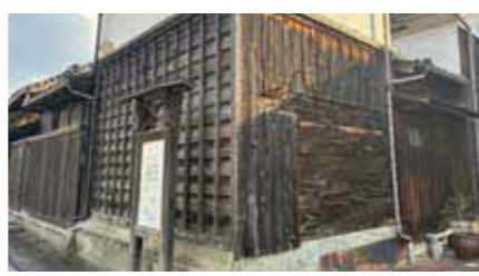
湯の山街道の「舟板壁」
